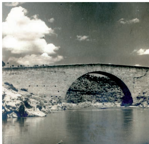
Río Cabriel y Puente de Vadocañas. 1941 Paso histórico entre los términos de Iniesta (Cuenca) y Venta del Moro (Valencia)
