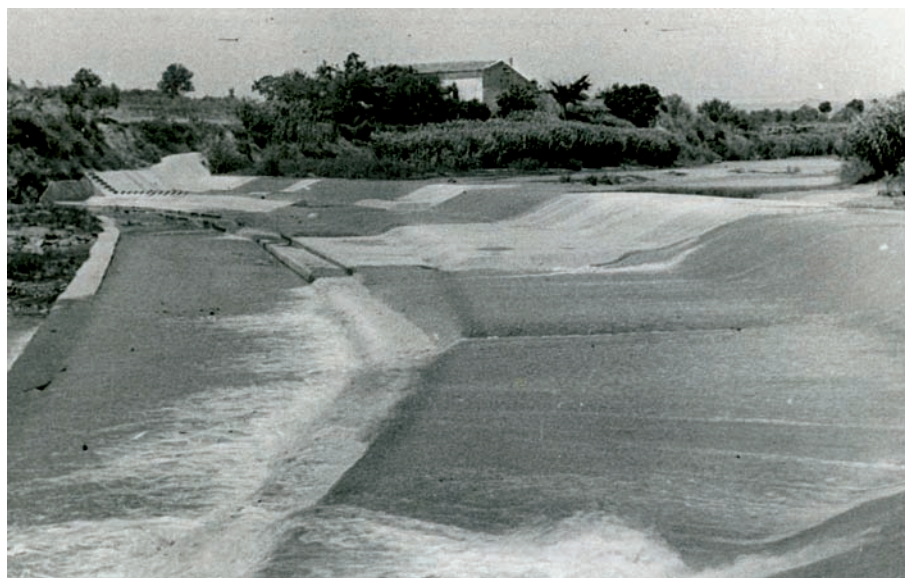
Azud de Lorca, Vilamarxant (Valencia). 2 de Julio de 1946 Toma de aguas en el río Turia
